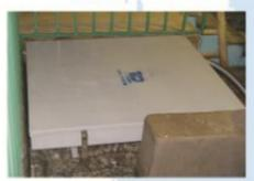
دستگاههای ضد عفونی آب تکنو آبی با شععه ماوراء بنفش اثر بخشی مناسب در کاهش عوامل باکتریایی و بیماریزا دارد. از مزایای دیگر دستگاه این است که بصورت انعکاسی عمل نموده و نصب و سرویس آسانی دارد. دستگاه در ظرفیتهای ۳ و ۶ لیتر در ثانیه تولید می شود و طبق سفارش در ظرفیتهای بالاتر قابلیت ساخت دارد.
