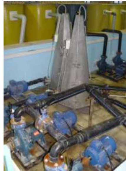
بخش سیرکولاسیون و اکسیژن دهی به آب
